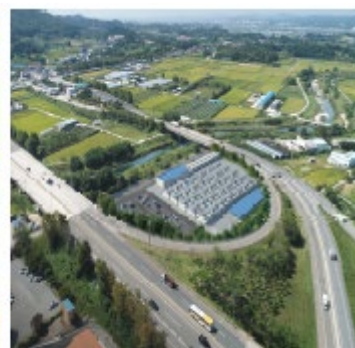
【燃料電池設備】
